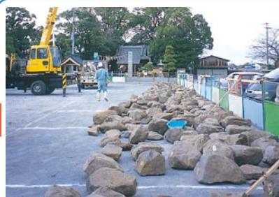
④ 解体した石は、番号順に並べます。
