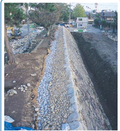
⑧ 石垣の上に立って天端のラインを見通すと、内側にゆるやかにカーブを描いているのがわかります。「輪どり」といって、石垣がくずれにくくするための技術です。復元は、わずかなカーブや傾斜にも気を配って行います。
