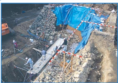
⑤ 丁張を張り、足場を組みます。
