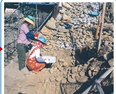
② 解体前に石垣の図面をとり、傾き等を調べ、復元のための資料を作ります。
