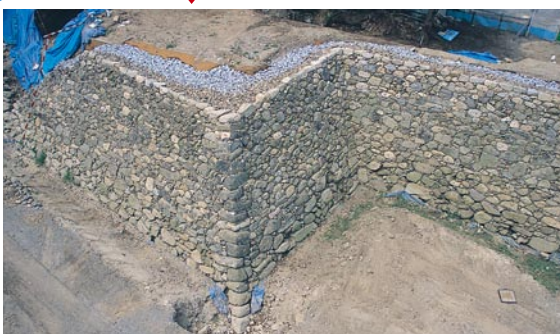
⑦ 完成しました。出角や入角(90°に折れている部分)は、左右両方の石がかみあう必要があるため、とても困難です。
