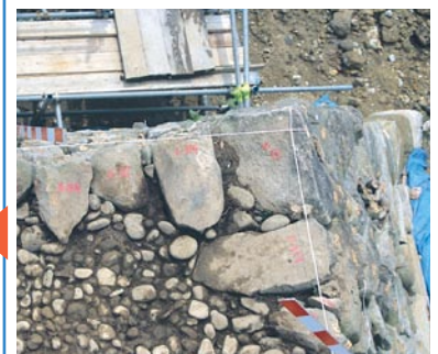
③ 解体中は1石ずつ計測し、裏込めの様子や石の積み方を観察します。
