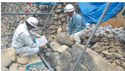
⑥ 写真や図面を参考に元通り積んでいきます。傷んだ石は交換します。長い年月くずれない様、何度も何度も積みなおします。
