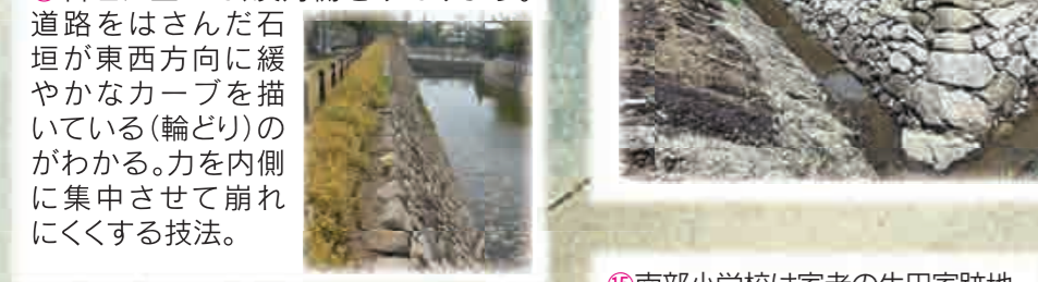
⑭石垣に登って、反対側をみてみよう。道路をはさんだ石垣が東西方向に緩やかなカーブを描いている(輪どりの)のがわかる。力を内側に集中させて崩れにくくする技法。
