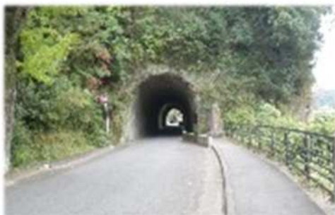
洞門隧道（本耶馬溪）
