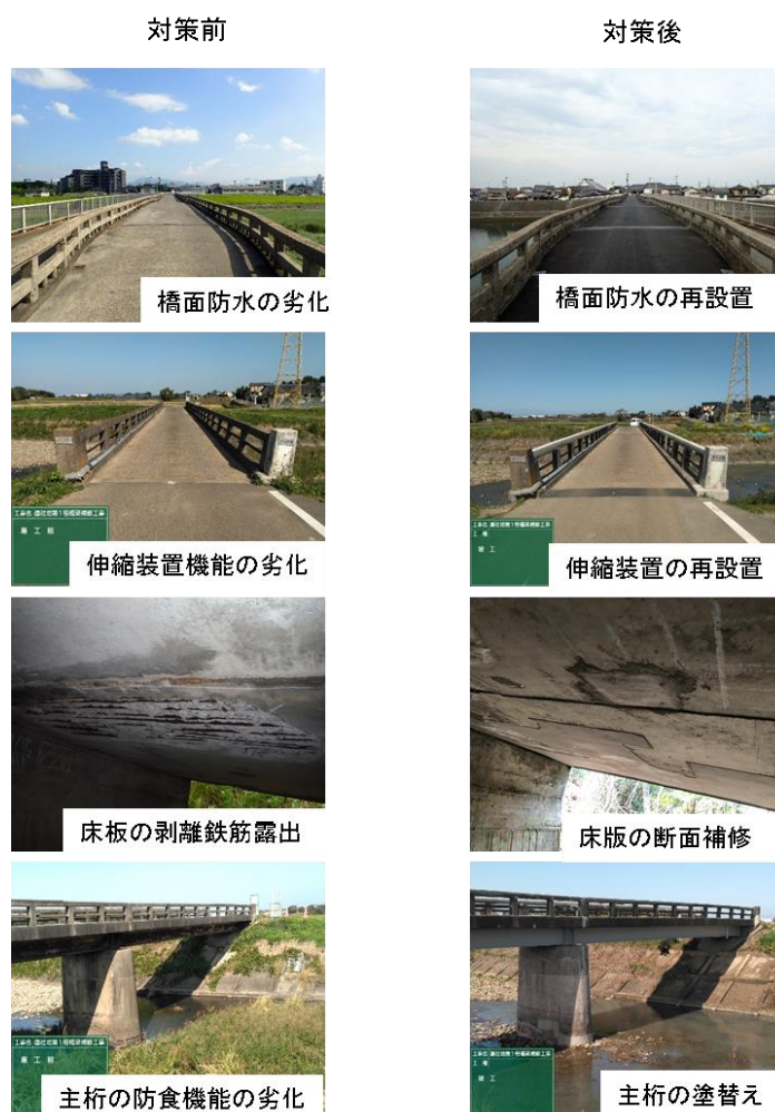
図-6 橋梁補修対策の事例写真
