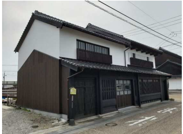
街なみ景観整備事業(改修後)
