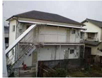
②メゾン寺町C棟
