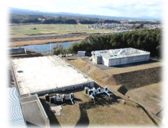
現在の三口配水池
