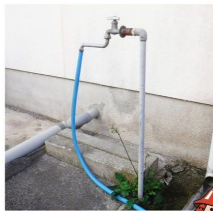
むき出しになっている水道管
