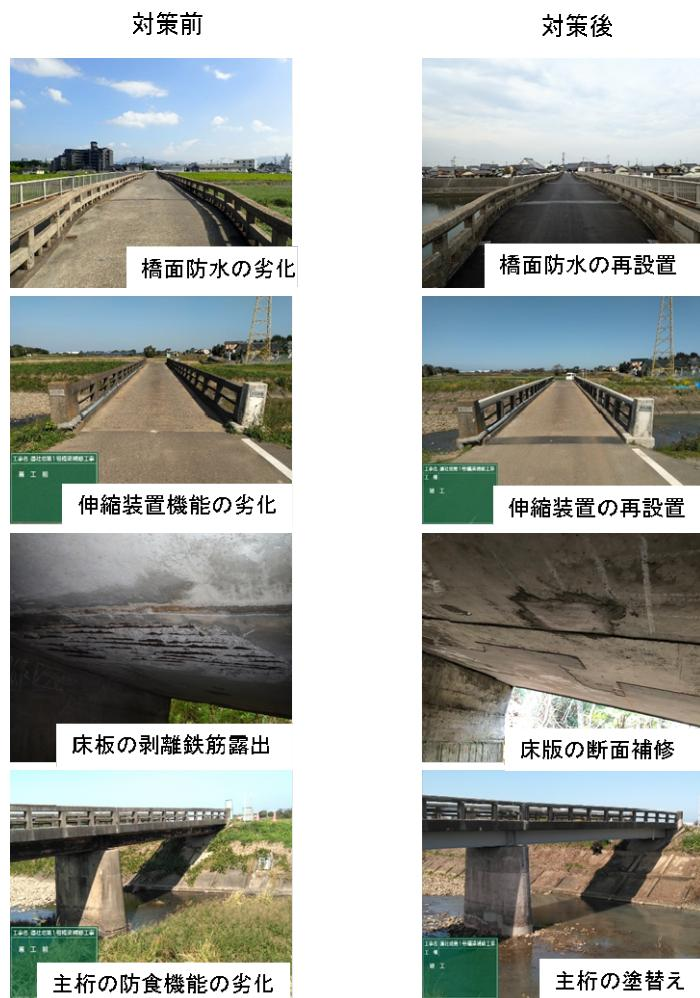
図-6 橋梁補修対策の事例写真
