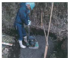
④基礎砕石 転圧状況
