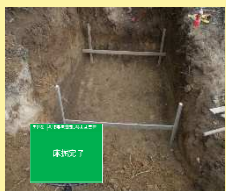
③床掘完了
