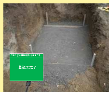
⑤基礎工完了
