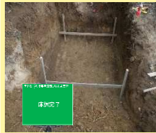
③床掘完了
