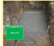
⑤基礎工完了
