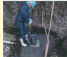
④基礎碎石 転圧状況
