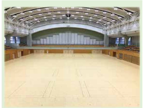
ダイハツ九州アリーナ 照明LED化・床改修事業
