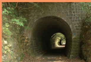
耶馬溪鉄道跡に残る厚ヶ瀬トンネル抜けると、名勝耶馬溪の鮎婦の溪・仏坂・大平山が耶馬溪へと誘う
