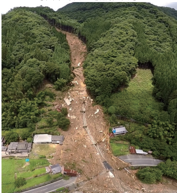
【中津市山国町 山腹崩壊の状況】
