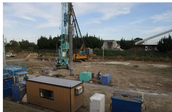
配水池増設工事
