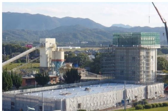
配水池増設工事
