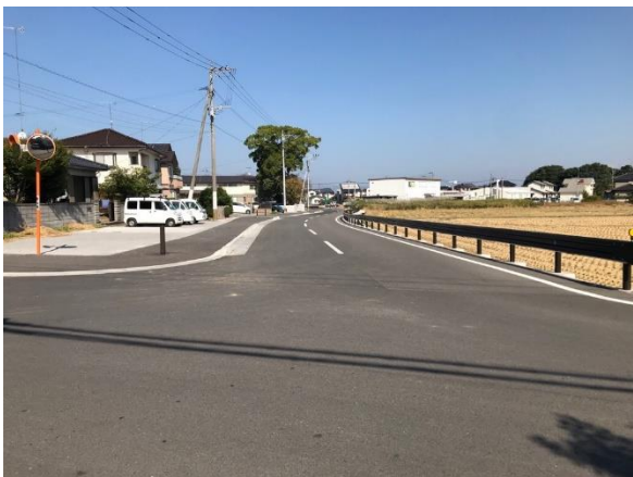
拡幅後の様子
